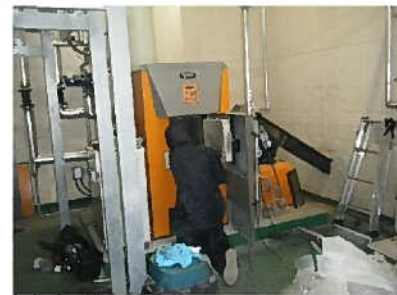
バイオマスボイラーの点検
